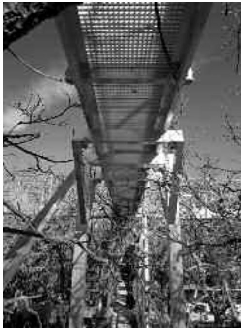
Photos 1 : Système de passerelles mis en place à l'O3HP : vue de la passerelle supérieure située à 3,5 m du sol (photo ci-dessus) et de la passerelle inférieure située à 80 cm du sol (photo ci-contre).
