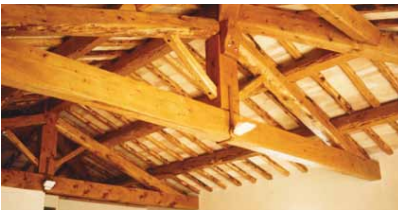
39 - Charpente en cèdre récolté au mont Ventoux.
